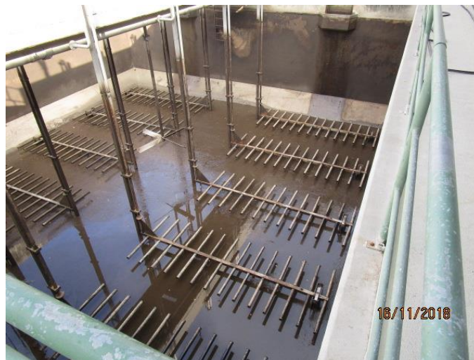
Abbildung: bestehende Belüftung
