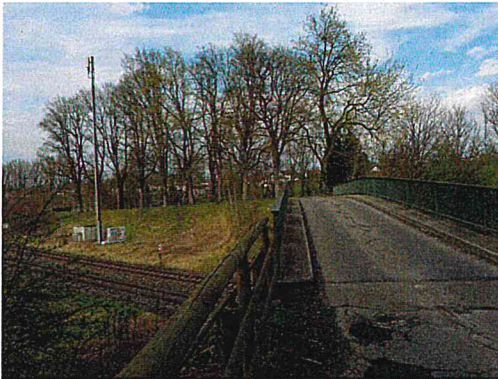
Blick auf die Fahrbahn der Bestandsbrücke
