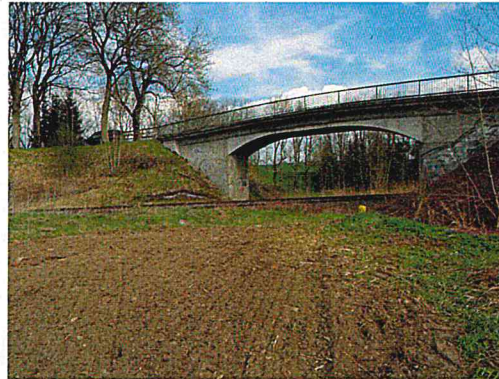
Bestandsbrücke mit Sicht auf die Bahnlinie
