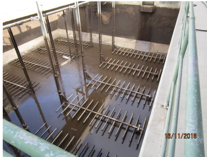
Abbildung: bestehende Belüftung
