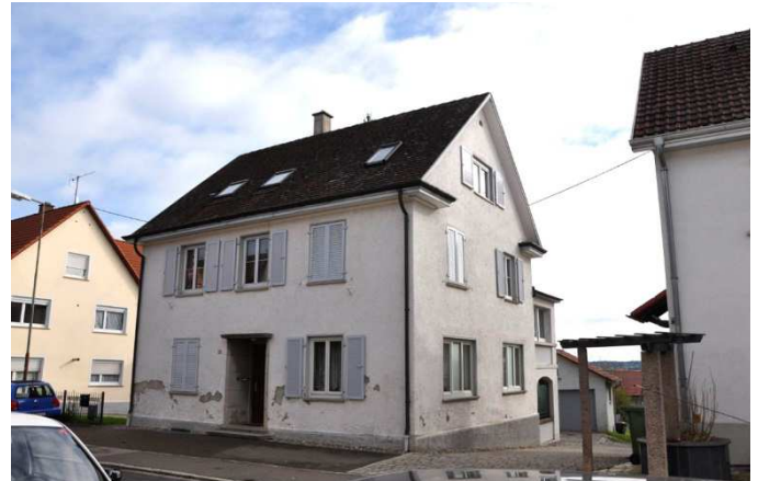
Eckstraße 63 , mittlerer Sanierungsbedarf
