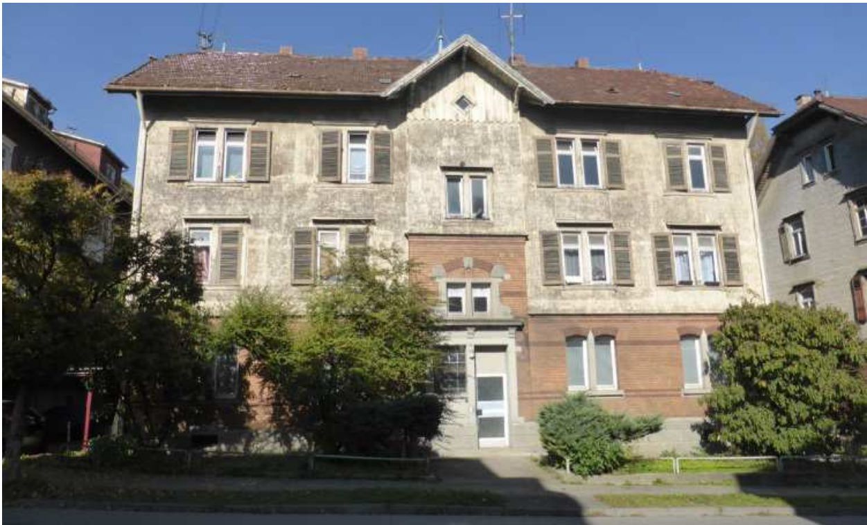
Bahnhofstraße 3 - Denkmal, umfassender Sanierungsbedarf
