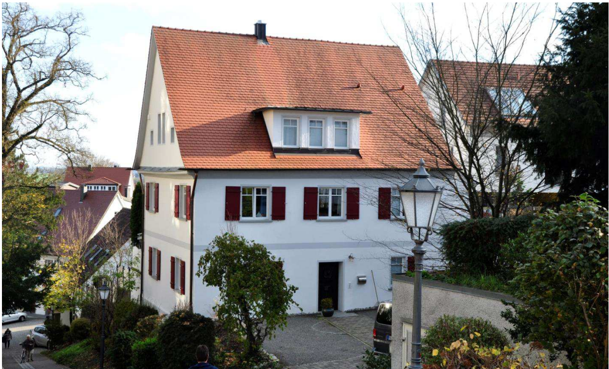
Modernisiertes Gebäude Schuhhalde 2
