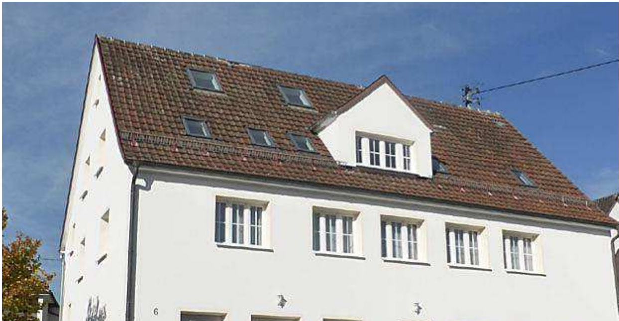
Bündig in Dachfläche eingebaute Dachflächenfenster Zollenreuter 6
