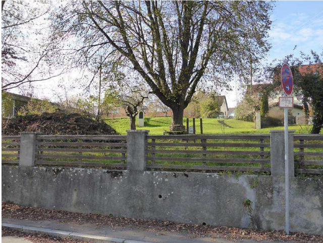
Großer Garten mit Steinmauer (Stützmauer) Schulstraße
