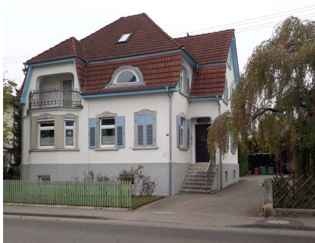
Treppenaufgang Zollenreuter Straße 16
