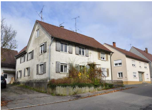
verputzter Fachwerkbau Eckstraße 82
