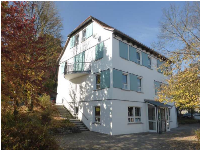
Moderne Fensterschiebeläden Pfarrhausgäßle 3
