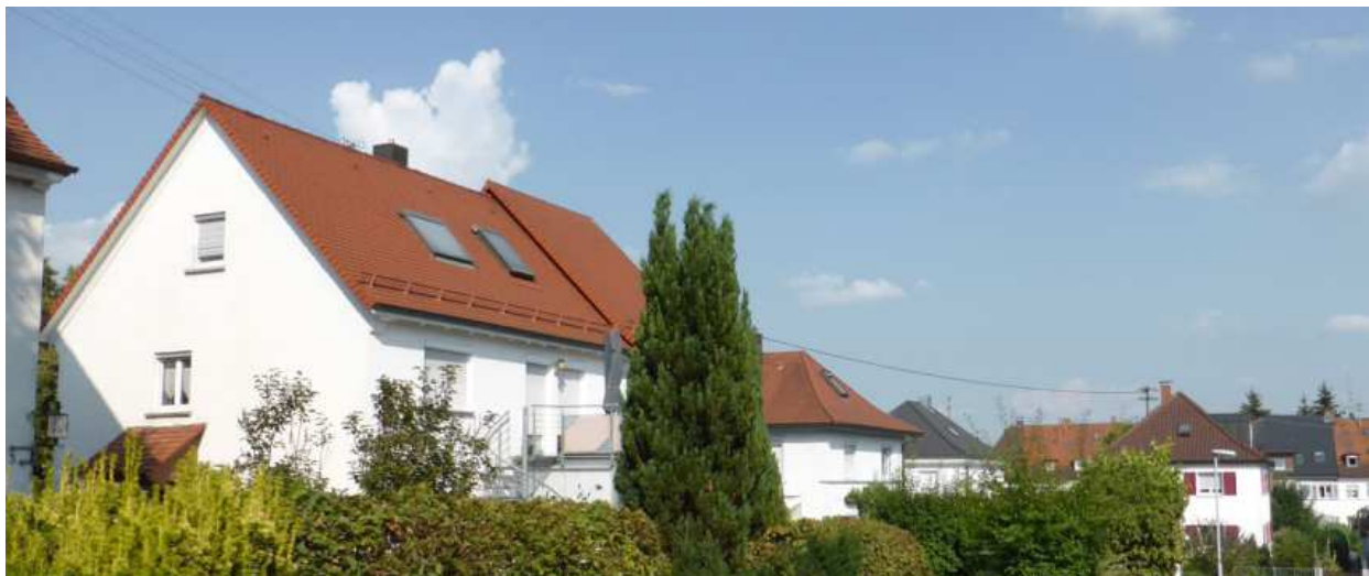
In Dachfläche eingebaute Dachflächenfenster Kneipstraße 5
