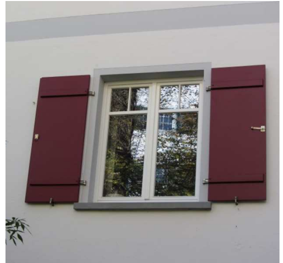
Einfache Holzklappläden Schuhhalde 2
