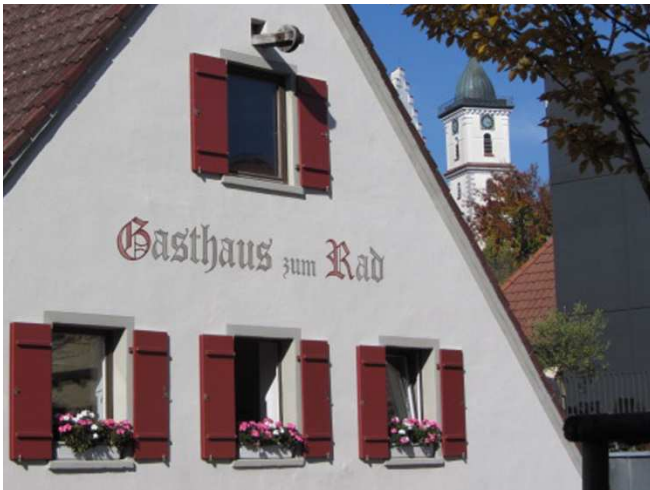
farbige Klappläden und Putzfasche Radgasse 1
