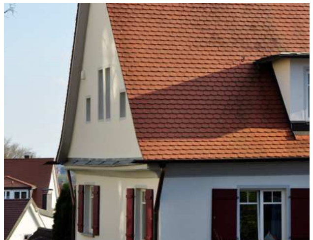
abgesetztes Gesims Schuhhalde 2
