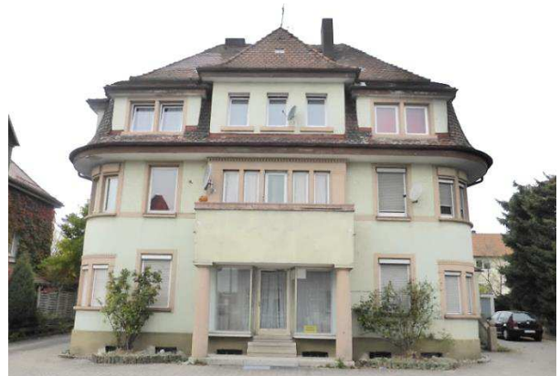
Zollenreuter Straße 18 - erhaltenswertes Gebäude
