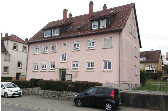
Zollenreuter Straße 42 umfassender Sanierungsbedarf
