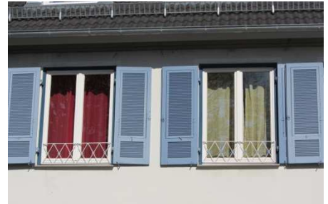
Kornhausstraße 1, Fenster Hochformat + 2-flügelig
