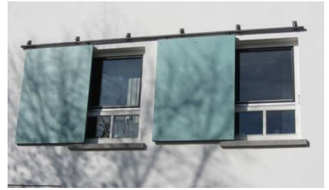
Pfarrhausgäßle 3, Fenster Hochformat + Unterlicht + Mittelsprosse
