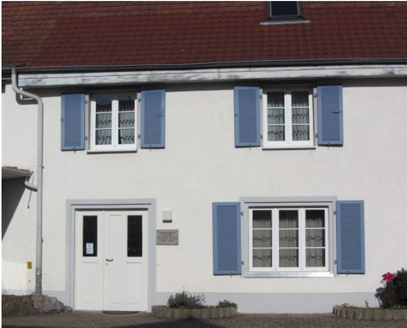
klare Fassadeneinteilung Bachstraße 3
