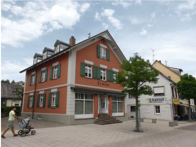
farbige Putzfassade Hauptstraße 48
