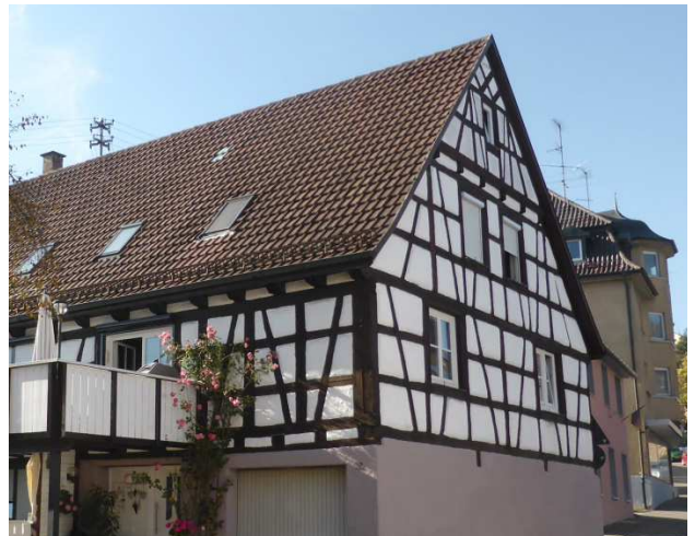
Sichtfachwerk natur Kolpingstraße 12
