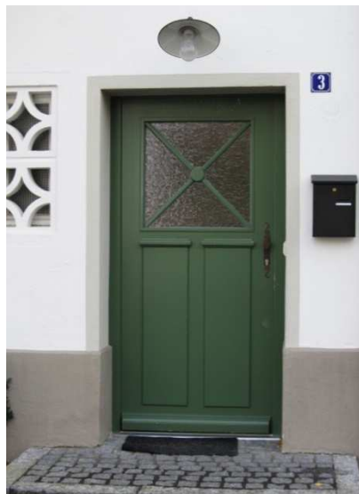
farbiges Türblatt + Putzfassade Im Gumpen 3
