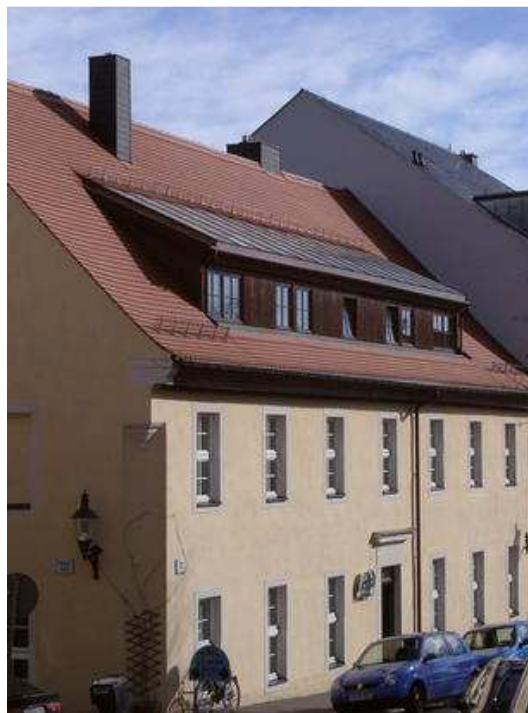
Solaranlage auf Schleppgaube (Foto: Solifer Solardach GmbH)
