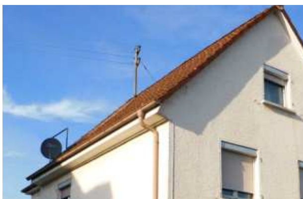
Ortgangziegel und Kastengesims Eckstraße 20
