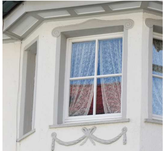
farbige Steingewände Bachstraße 6
