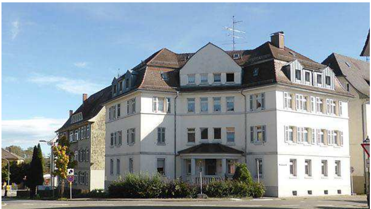
Sonderform des Zwerchgiebels Bahnhofstraße 2
