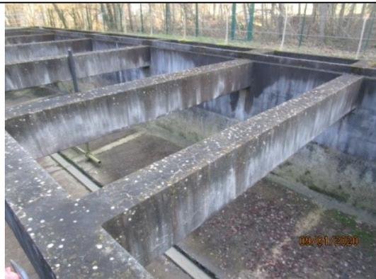
Stahlbetonbalken für optionale Abdeckung
