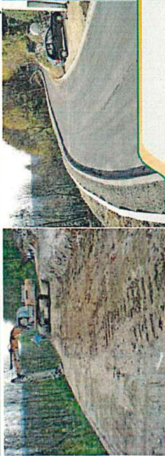
Sanierung von bereits geneigten Böschungen mit Erdbetonstützschichten
