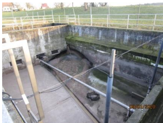
Trockenwetterführung quer über Sohle
