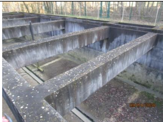
Stahlbetonbalken für optionale Abdeckung
