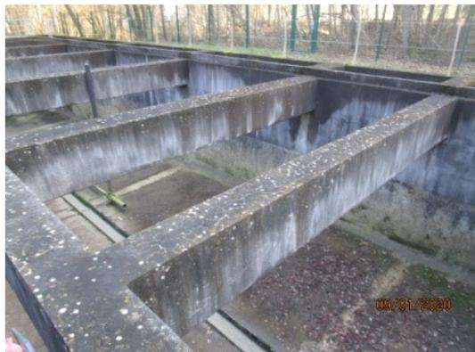
Stahlbetonbalken für optionale Abdeckung
