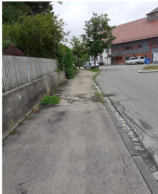
Außerdem sind einige Randsteine abgesagt bzw. beschädigt, welche im Rahmen der Gehwegarbeiten erneuert werden, sowie die Fläche um den Straßeneinlauf bei Haus Nr. 8, welche derzeit tiefer liegt als der Einlauf selbst und sich zudem in einem desolaten Zustand befindet. Auch für diesen Bereich ist laut der Straßenbewertung aus 2017 der Warnwert bereits überschritten. Die Kostenschätzung beläuft sich auf ca. 25.000 €.
