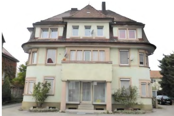
Zollenreuter Straße 18 - erhaltenswertes Gebäude
