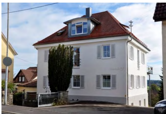
Eckstraße 57 - erhaltenswertes Gebäude
