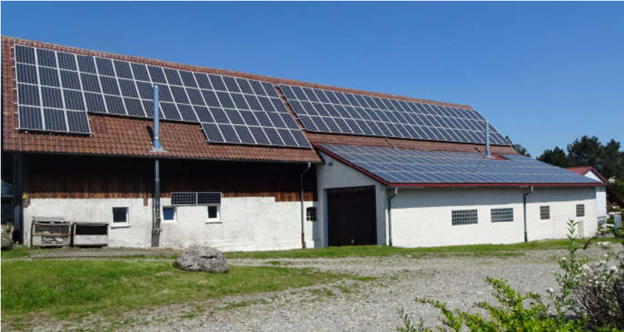
Abbildung 2: Abzubrechendes Lagergebäude von Süden, 18.05.2020
