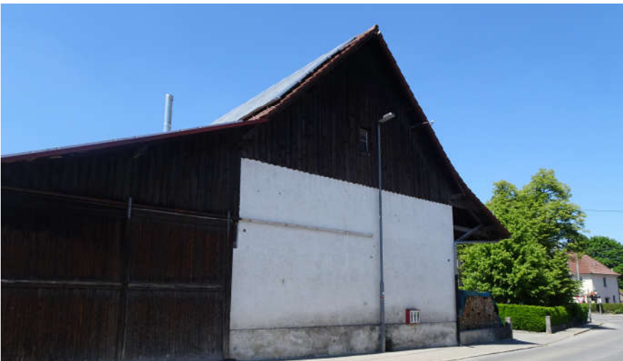
Abbildung 3: Abzubrechendes Lagergebäude von Osten, 18.05.2020
