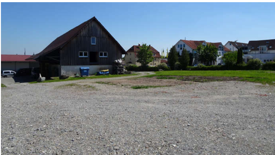
Abbildung 4: Abzubrechendes Lagergebäude von Westen, 18.05.2020
