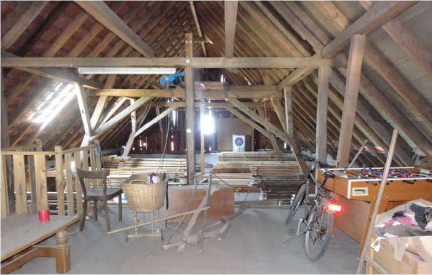
Abbildung 5: Dachboden des Lagergebäudes, 18.05.2020
