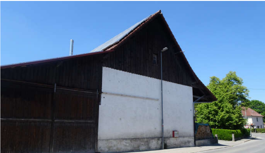
Abbildung 3: Abzubrechendes Lagergebäude von Osten, 18.05.2020
