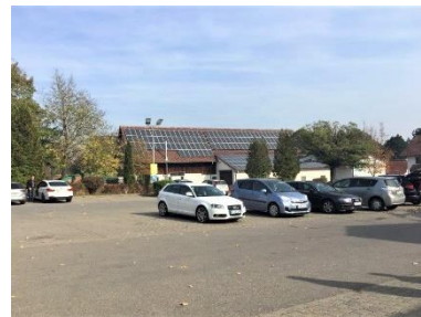
Abb. 4 Lagergebäude und Parkplatz
