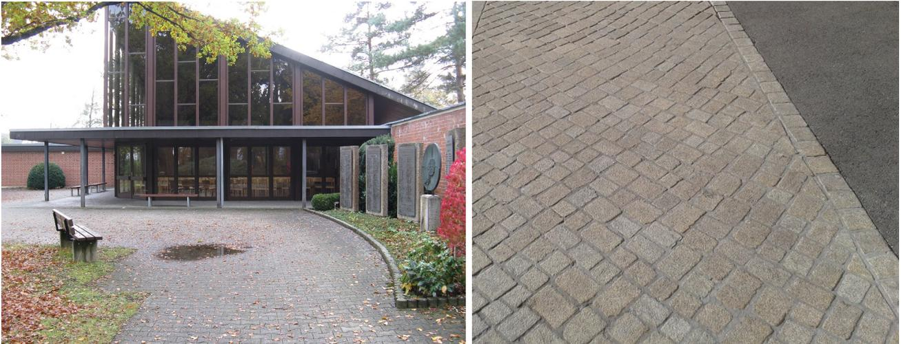
Der Betonverbundsteinbelag sollte angehoben werden, damit das Regenwasser vollständig in den Einlaufschacht fließen kann. Zudem sollte die Fläche unter der Sitzbank mit, in einem Mörtelbett verlegten, gestockten Granitpflastersteinen gepflastert werden. Dies würde zu einer komfortableren Nutzung und vereinfachter Pflege des Bankplatzes führen.
