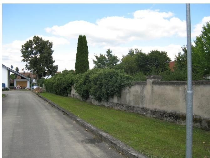
Die komplette Friedhofsmauer sollte von allen Efeupflanzen befreit werden. Bei stark eingewachsenen Mauern kann nicht mehr festgestellt werden, ob die Abdeckplatten zuverlässig ein Eindringen von Wasser in die Mauer verhindern. In die Mauer eindringendes Wasser führt mittelfristig zu starken Mauerschädigungen.
