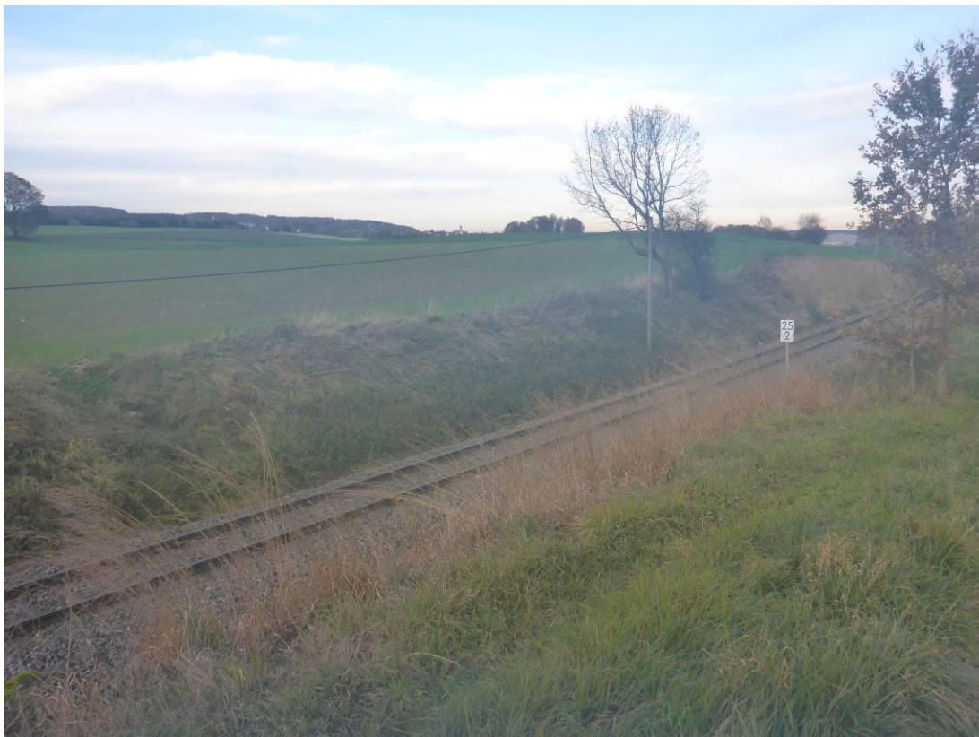
Die Bahnstrecke liegt eingeschnitten nördlich des Vorhabensgebiets
