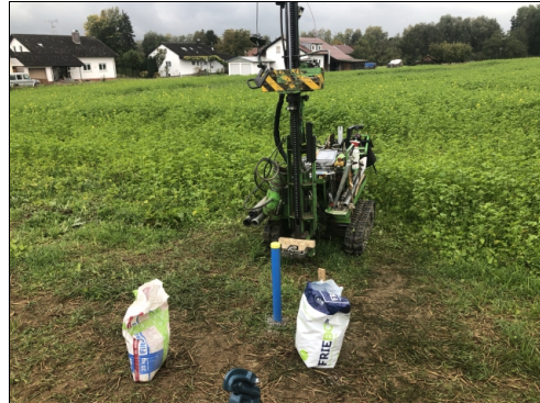
Abbildung 3: Messpegel P-1 nach Fertigstellung
