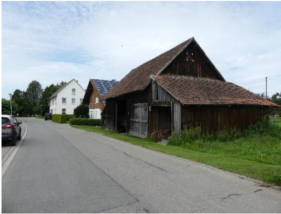
Abbildung 2: Tannhauser Straße (nach W)
