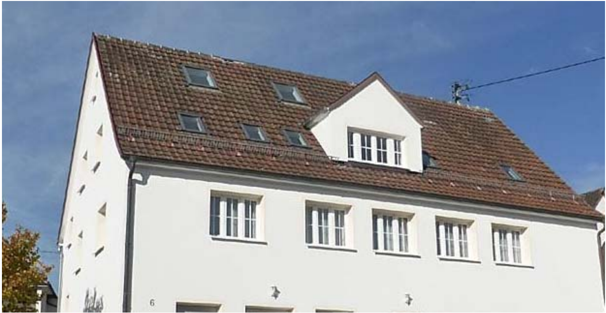
Bündig in Dachfläche eingebaute Dachflächenfenster Zollenreuter 6
