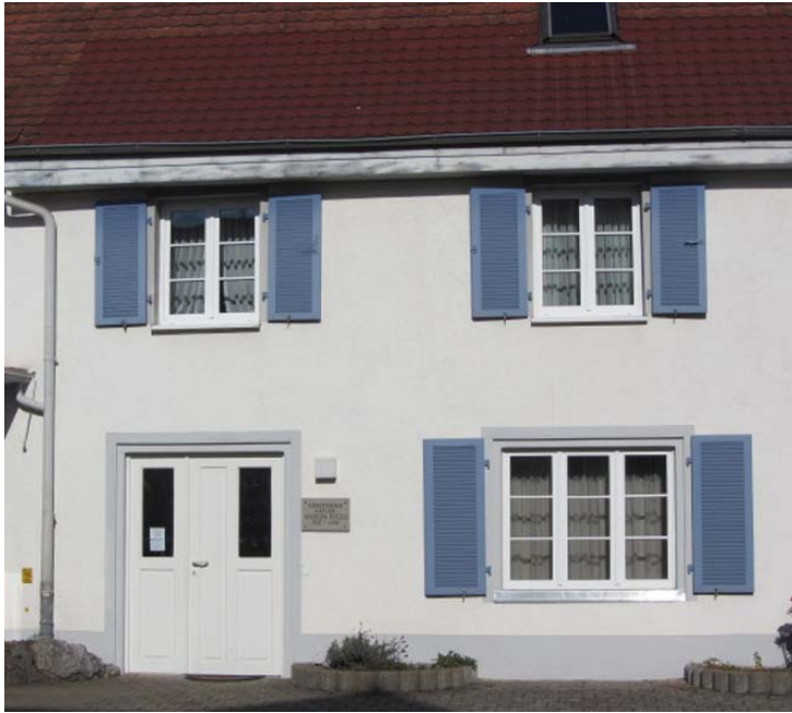
Klare Fassadeneinteilung Bachstraße 3
