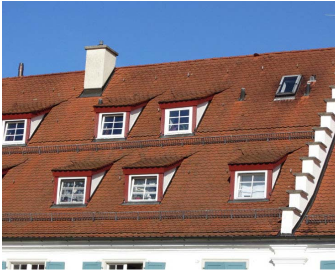
Wirtschaftsgebäude - Schlossensembel mit Schleppgauben
