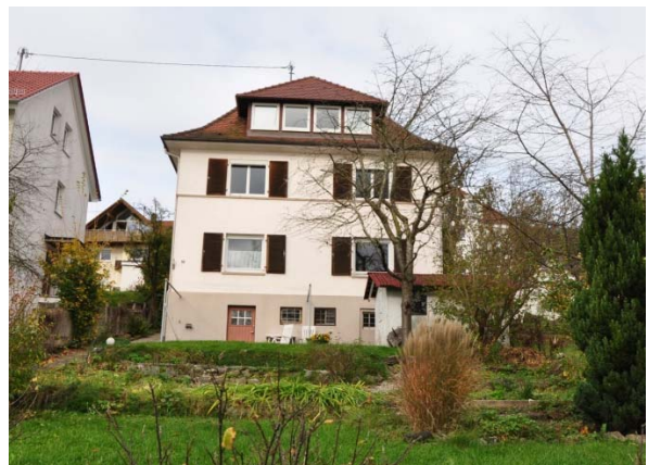
Schulstraße 44, guter Sanierungsstand
