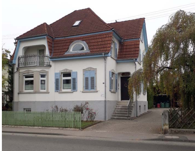
Treppenaufgang Zollenreuter Straße 16
