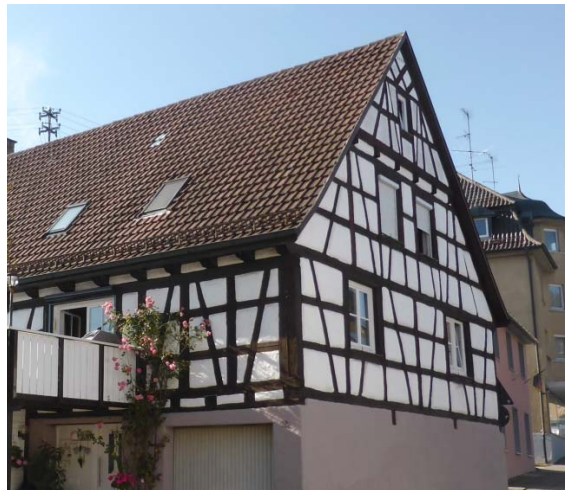
Sichtfachwerk natur Kolpingstraße 12
