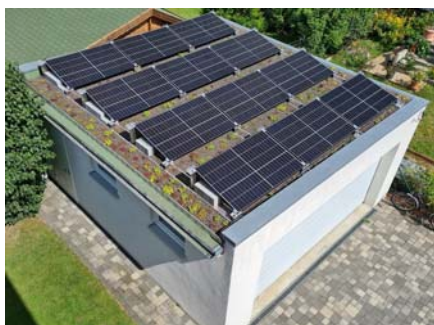
Bsp. Flachdach begrünt mit PV-Anlage https://www.photovoltaikeforum.com/ R.Mueller
