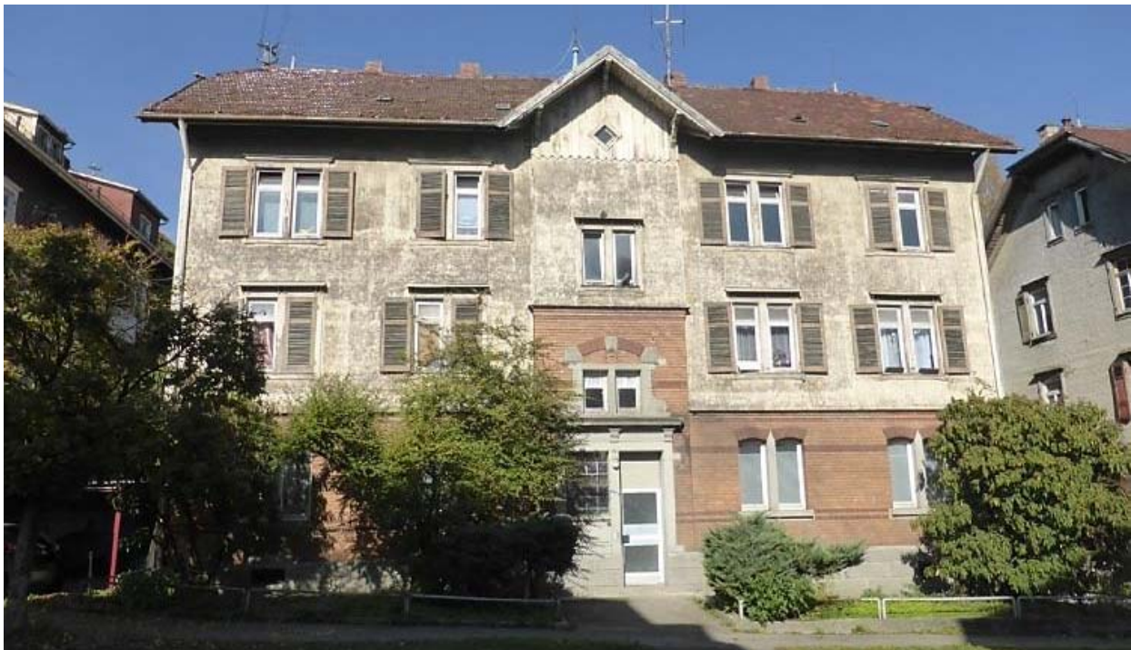
Bahnhofstraße 3 - Denkmal mit umfassendem Sanierungsbedarf, ehemalige Bahngelände
