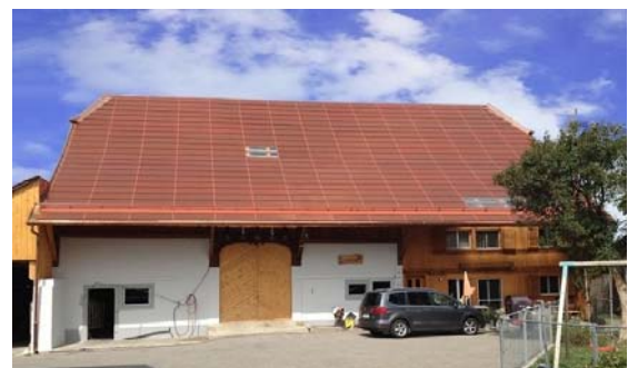
Farbige PV-Module, in Dachfläche integriert bzw. vollflächig
