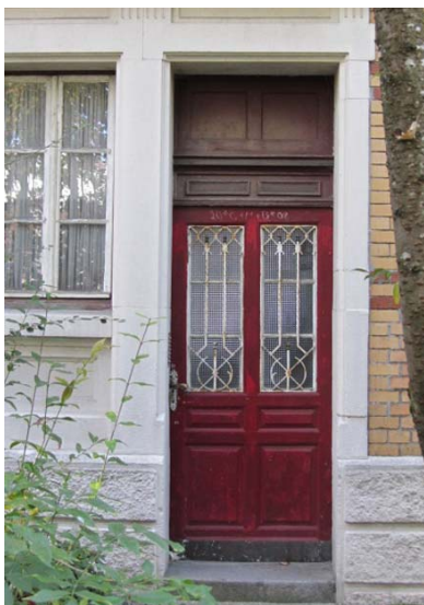
Haustür mit Natursteingewände Bahnhofstr. 1
