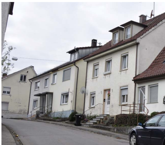
Außentreppen mit Sanierungsbedarf, Eckstraße
