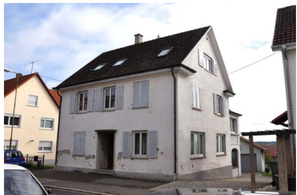
Eckstraße 63 , mittlerer Sanierungsbedarf
