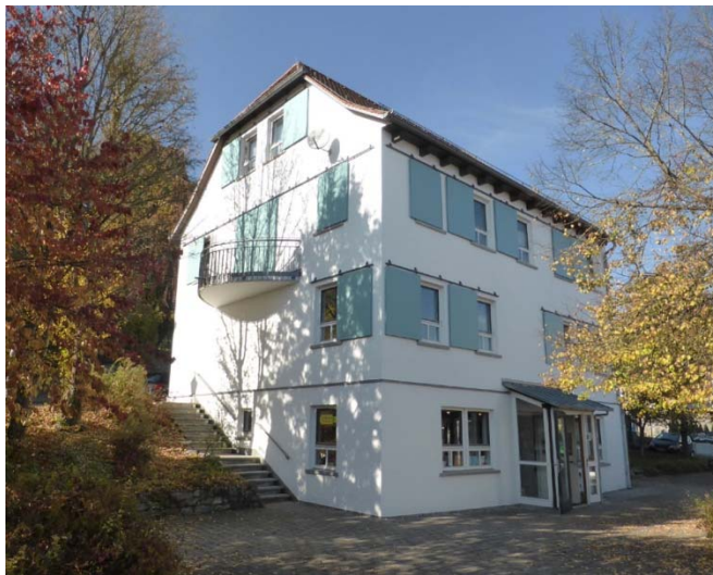
Moderne Fensterschiebeläden Pfarrhausgäßle 3
