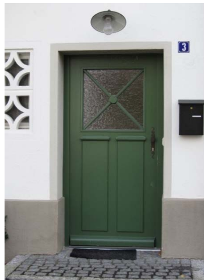
farbiges Türblatt + Putzfassade Im Gumpen 3
