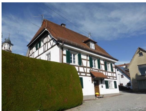
Unterschiedliche Dachneigungen Hauptstr. 108 und 106
