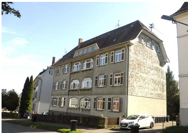
Bahnhofstraße 4, mittlerer bis umfassender Sanierungsbedarf
