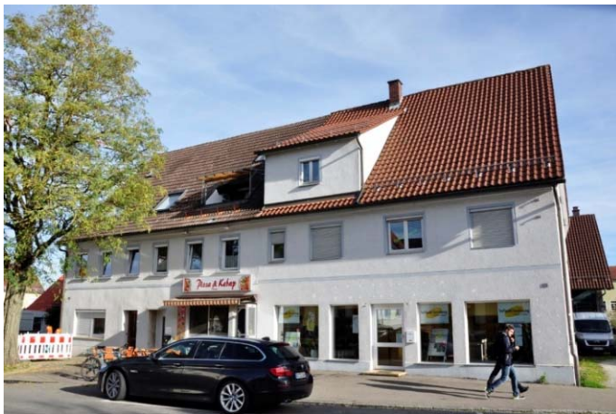
Schaufenstereinteilung mit Bezug zur übrigen Fassade Hauptstraße 81 und 83
