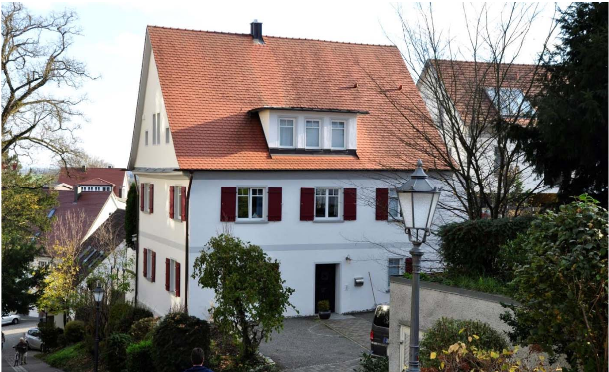
Gebäude Schuhhalde 2 - Erhaltenes Gebäude, stadtbildgerecht saniert und gestaltet
