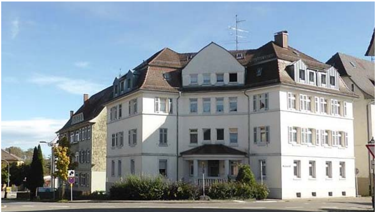
Sonderform des Zwerchgiebels Bahnhofstraße 2
