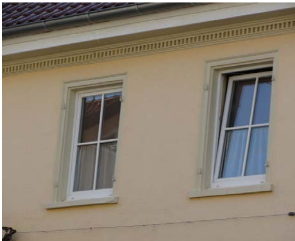
farbiges Gesims Hauptstraße 68
