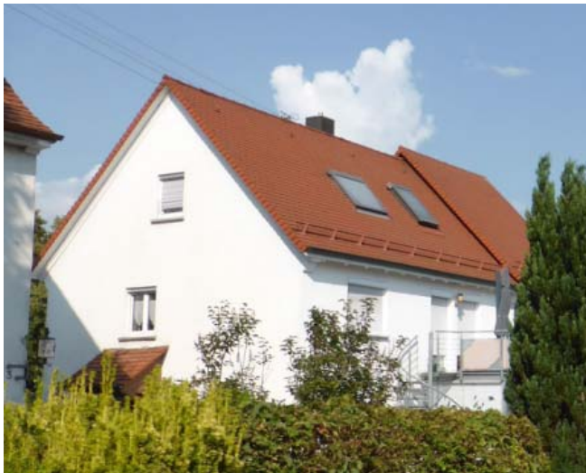
In Dachfläche eingebaute Dachflächenfenster Kneipstraße 5
