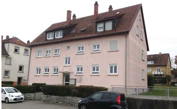
Zollenreuter Straße 42 umfassender Sanierungsbedarf
