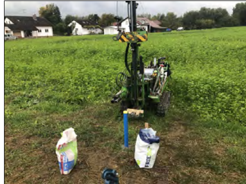
Abbildung 3: Messpegel P-1 nach Fertigstellung
