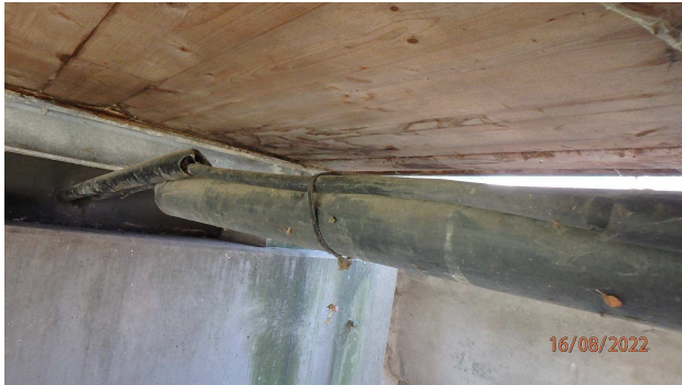
2022E_SCHADEN_4_SCHUTZROHRE SCHADHAFT
