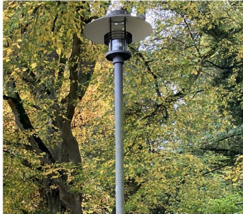
Hess Leuchte vorhanden mit Lamellen
