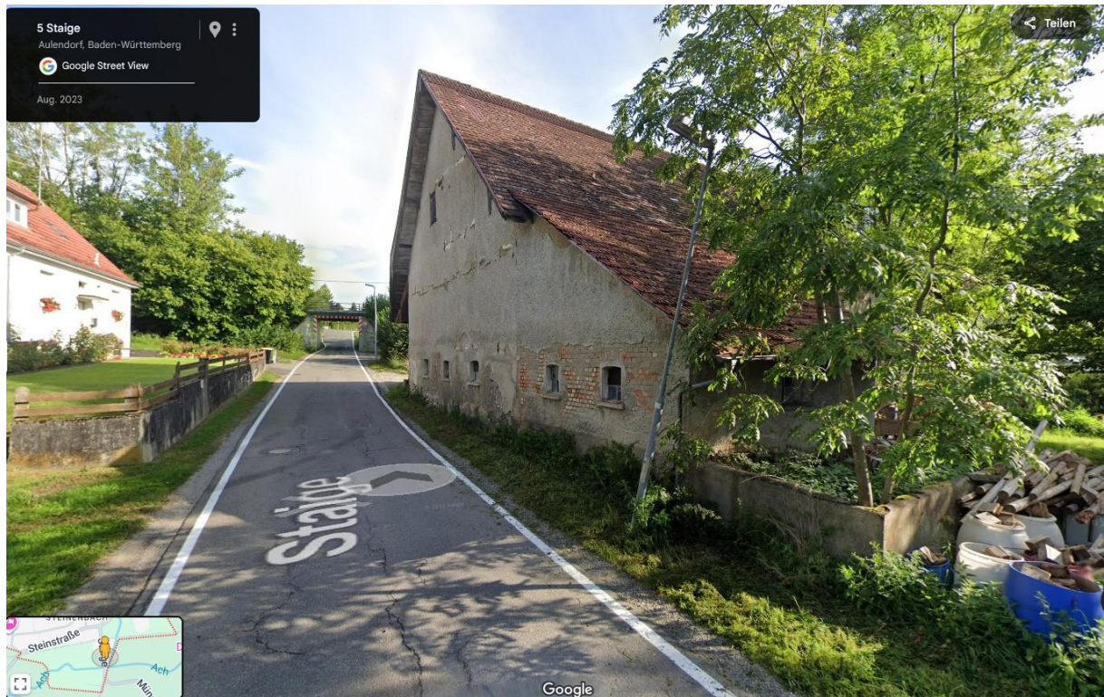
Abbildung 8: Blick entlang Staige Richtung Norden zur Bahnlinie. Das rechte landw. Gebäude wurde bereits abgerissen.
